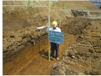
支持地盤確認 (場所によって支持地盤の深さが変化)
