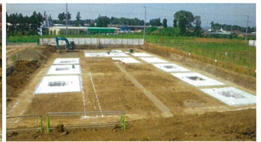
地盤改良 (布基礎下部を格子状に改良)
