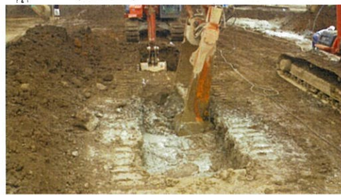
地盤改良 (布基礎下部を格子状に改良)
