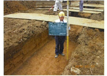
支持地盤確認 (場所によって支持地盤の深さが変化)
